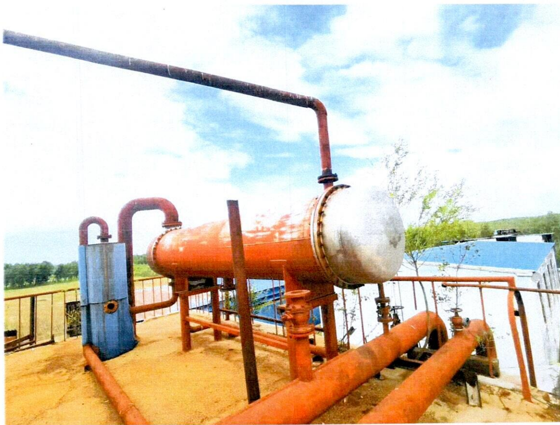
4、精制精馏塔冷凝器一台 换热面积：100 m 2 材质：304
