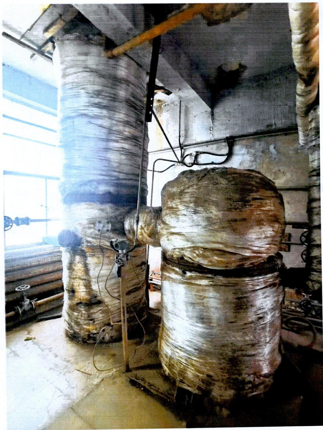
2、精制精馏塔一台 直径 1000mm, 材质 304/316l
